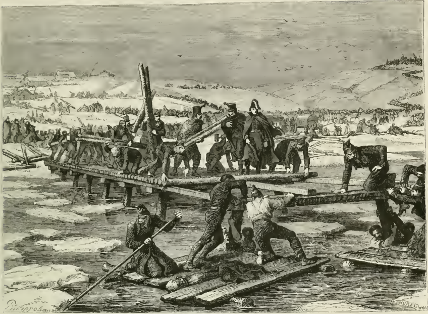
Construction des p. n. s. sur la Bérésina.
